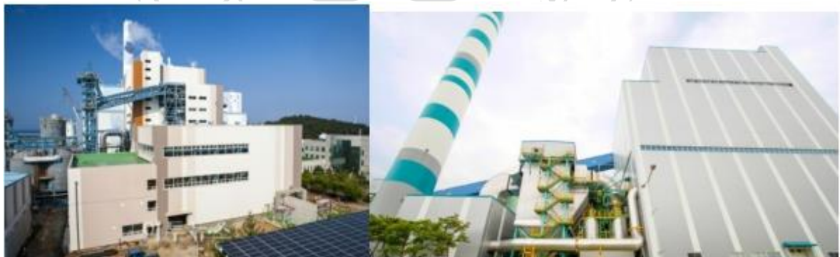
圖 3-9 韓國東西電力東海發電廠與唐津發電廠
