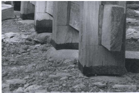
圖 39 柱子置於地基石上（撒韻武荖拍攝）
