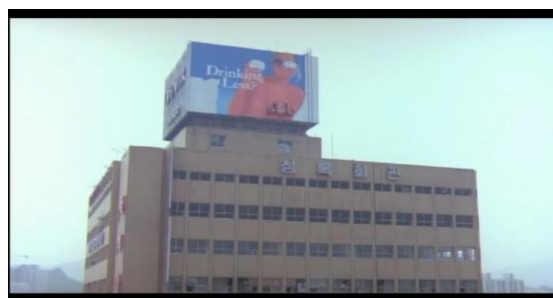
(照片 9) 廣告版在高樓之頂樓上
