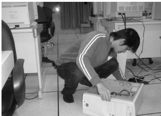
圖五 電腦硬體故障-現場檢測維護
