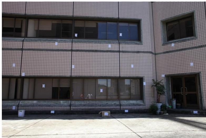
圖6 Canon EOS 5D Mark II 相機 28mm 鏡頭的相機率定場
