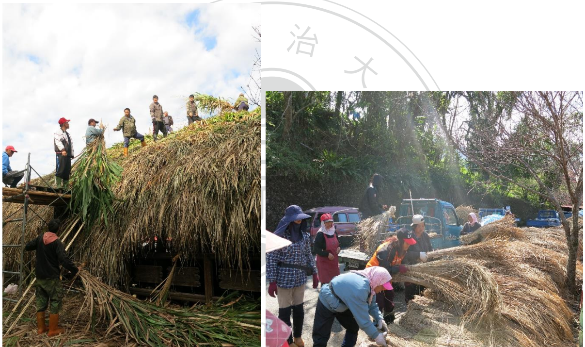
（圖一）協力將芒草鋪設成庫巴屋頂（圖二）將芒草從貨車上取下整齊排列
