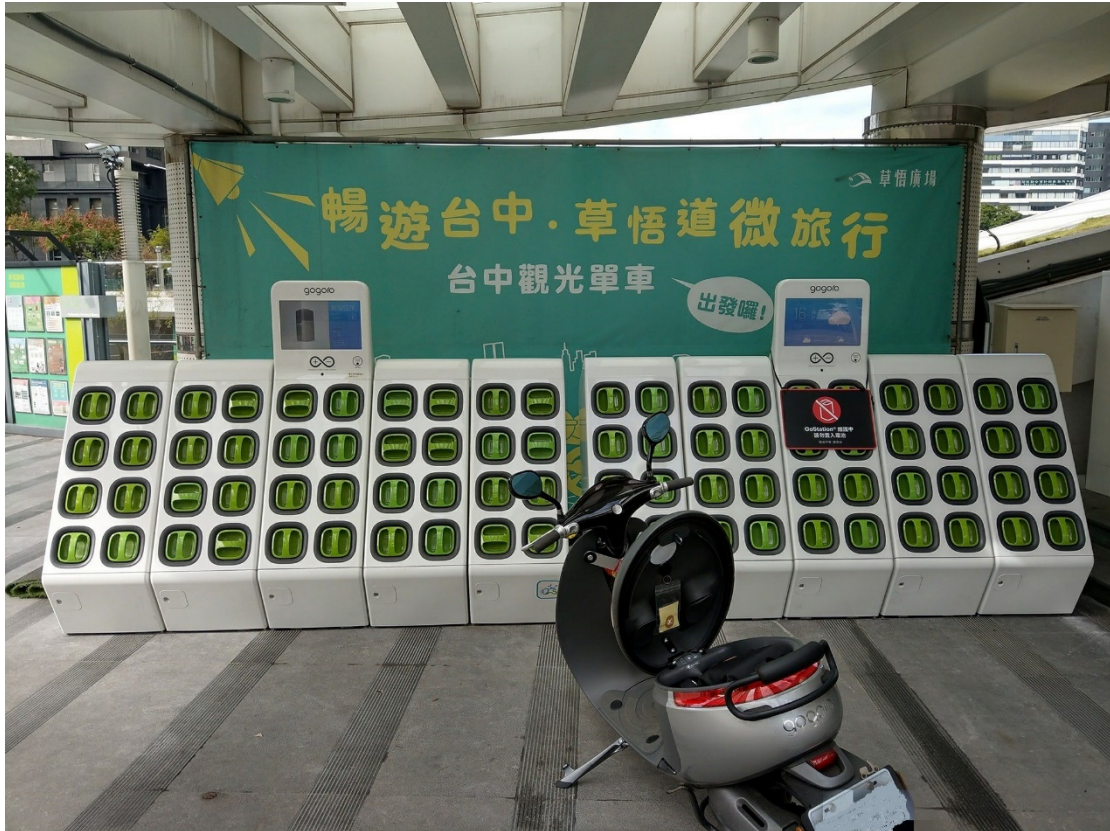
圖 5-2：台中草悟廣場的 GoStation 換電站，具有兩座母機與八組子機
