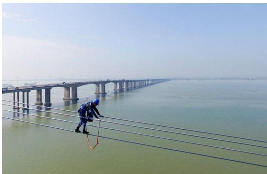
圖 1-1. 傳統人力電纜巡檢
