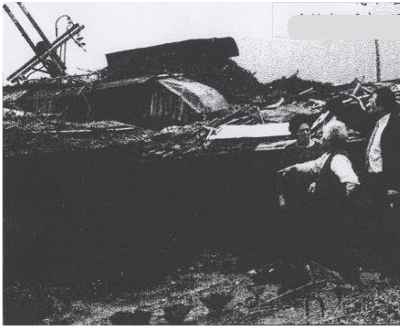
圖 5-1：電線桿倒塌，壓垮民宅屋頂圖
