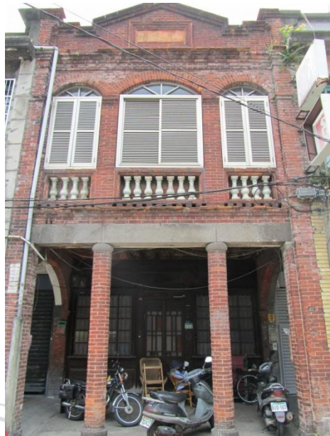
圖 4-9：迪化街一段 252 號洋樓 建築 圖片來源：永樂國小鄉土教學網站
